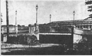
สะพานเฉลิมวัง ๔๗ ข้ามคลอง สะพานผ่าน (หรือคลองหลอดวัดราช บพิตร) (ที่เห็นกองๆ อยู่ น่าจะเป็นกอง ผ่าน?)
